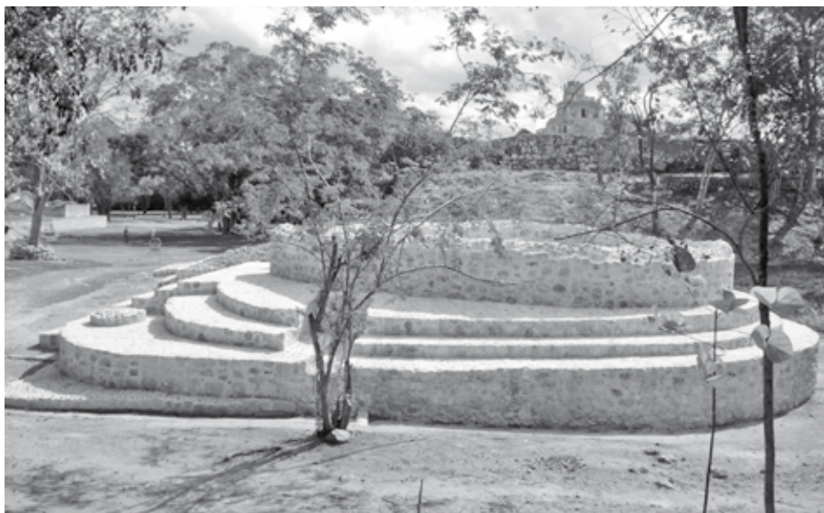
Figura 7.11. Lado poniente de la Estructura 425. Al fondo alcanza a verse el Edificio de los Cinco Pisos.
