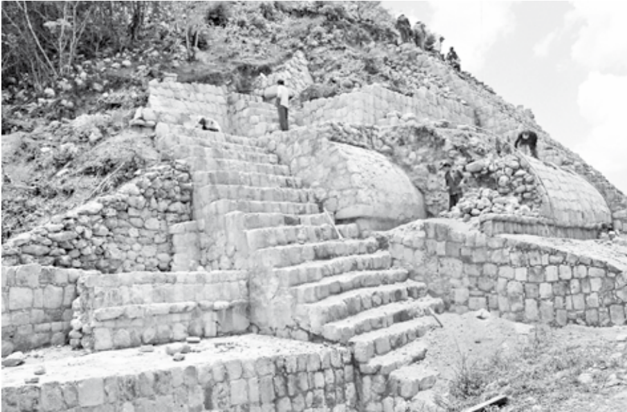
Figura 4.10. Lado norte del Edificio de los Cinco Pisos (sector noreste).
