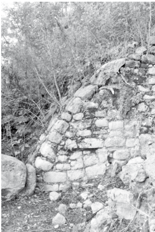
Figura 5.24. Molduras voladas o en delantal, in situ, localizadas a la altura del cuarto cuerpo de la Estructura 501.
