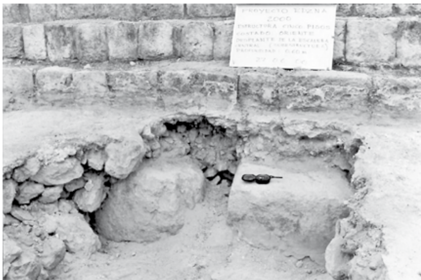
Figura 4.14. Bajo la escalinata central del lado oriente del Edificio de los Cinco Pisos se registraron los vestigios de una escalinata petenera armada con grandes bloques.
